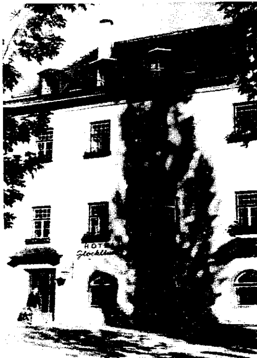
Das Hotel „Glöcklturm“ heute.
